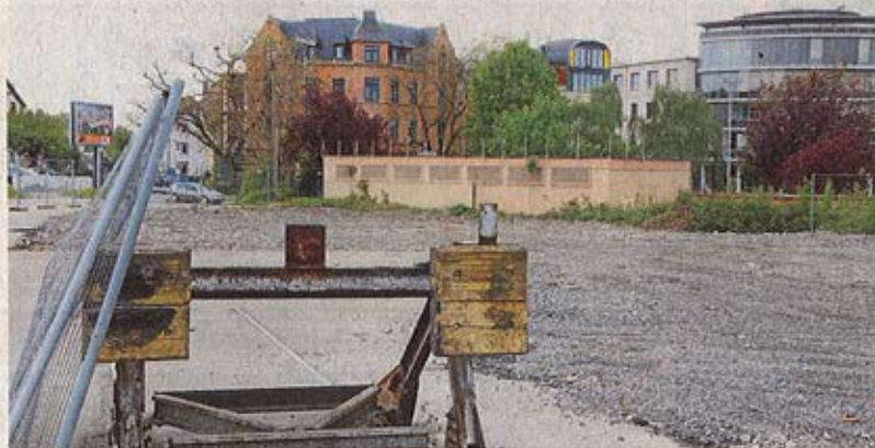
Die Trafostation der Zeag wird im neuen Ärztehaus beim Rathenauplatz integriert. Baustart soll im Oktober sein.
